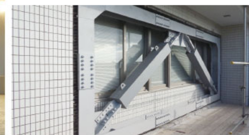
事務所耐震補強工事 【設計／維持保線】 静岡県磐田市
