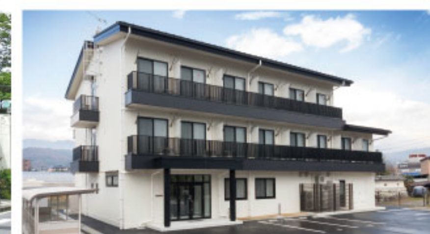
独身寮新築工事 【設計／建設】 長野県飯田市
