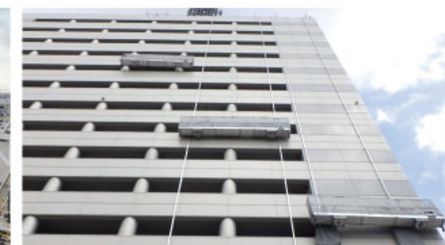
外壁改修工事 【設計／維持保全】 名古屋市中区
