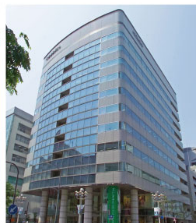
大津通電気ビル 名古屋市中区
