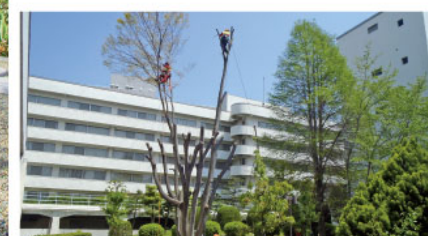
ロープクライミング工法 愛知県日進市
