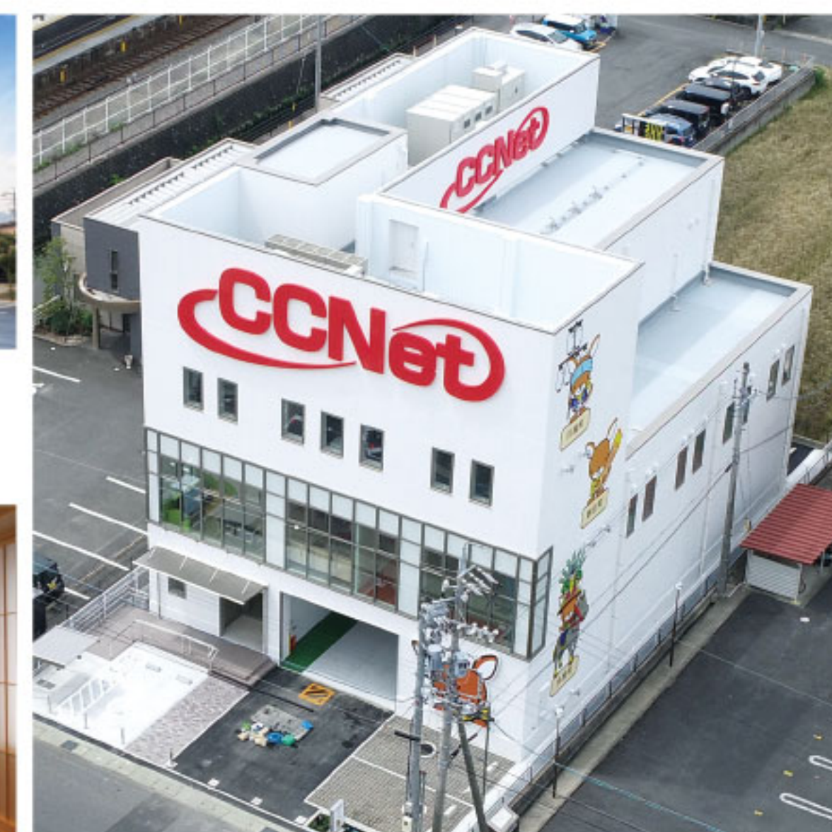
事務所（スタジオ）新築工事 【設計／建設】 三重県三重郡
