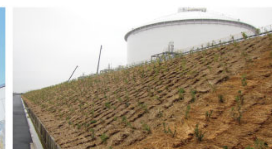
工場緑化工事 三重県川越市
