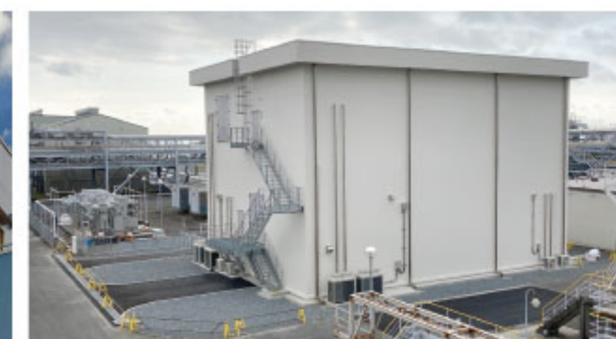
電気所新築工事 【設計／建設】 三重県三重郡
