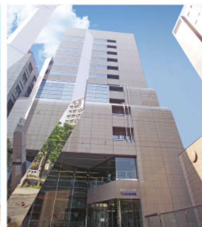
電気文化会館 名古屋市中区
