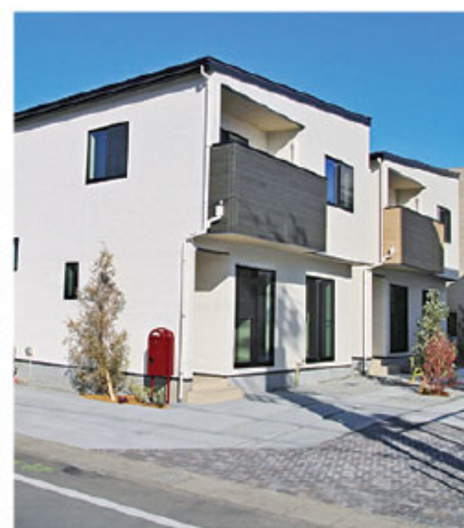
C's安東 静岡市葵区
