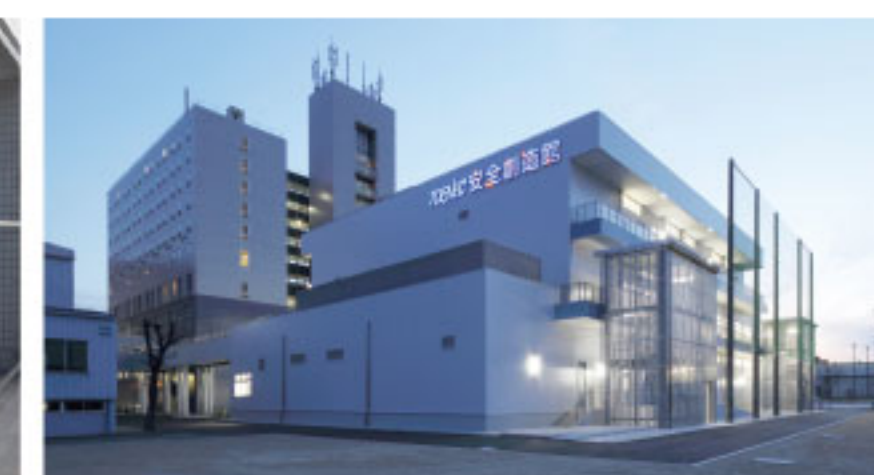
研修施設新築工事 【設計／建設】 名古屋市中区
