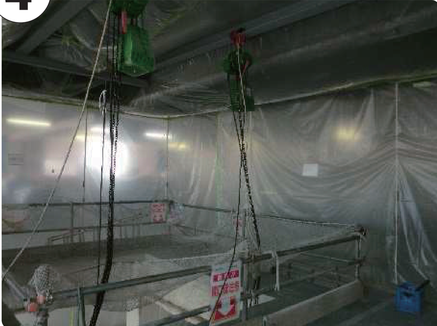
4 チェーンブロックで吊りながら切断
