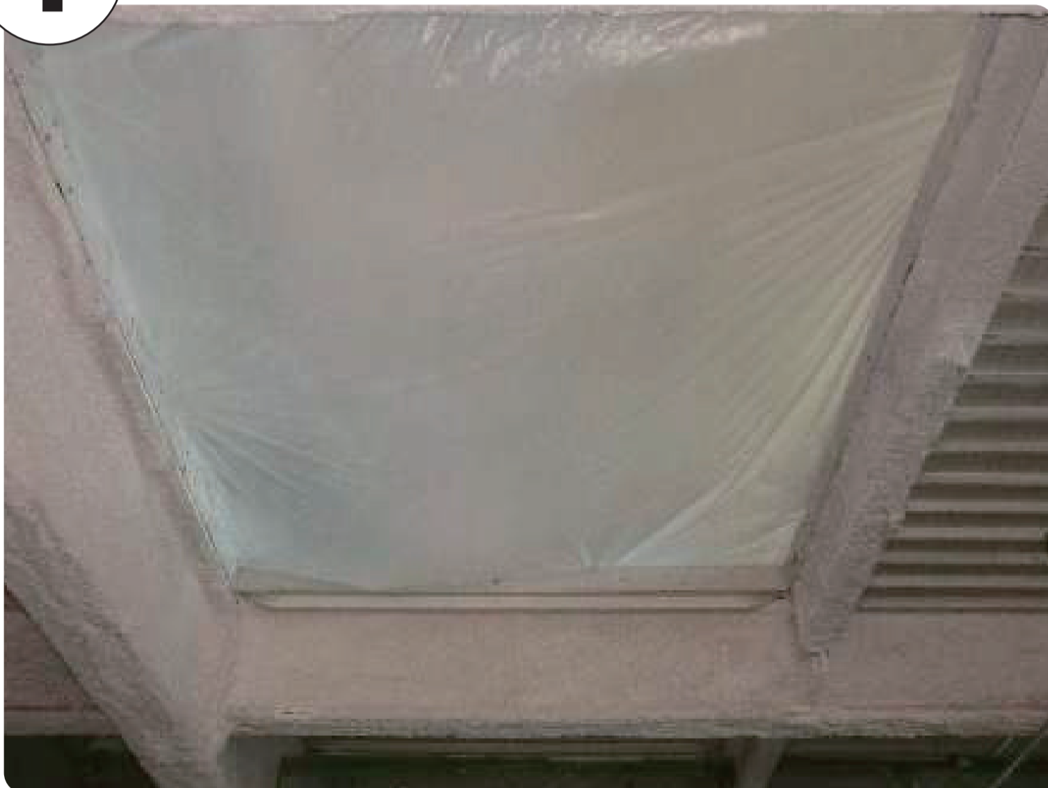
1 3階床スラブ下の養生
