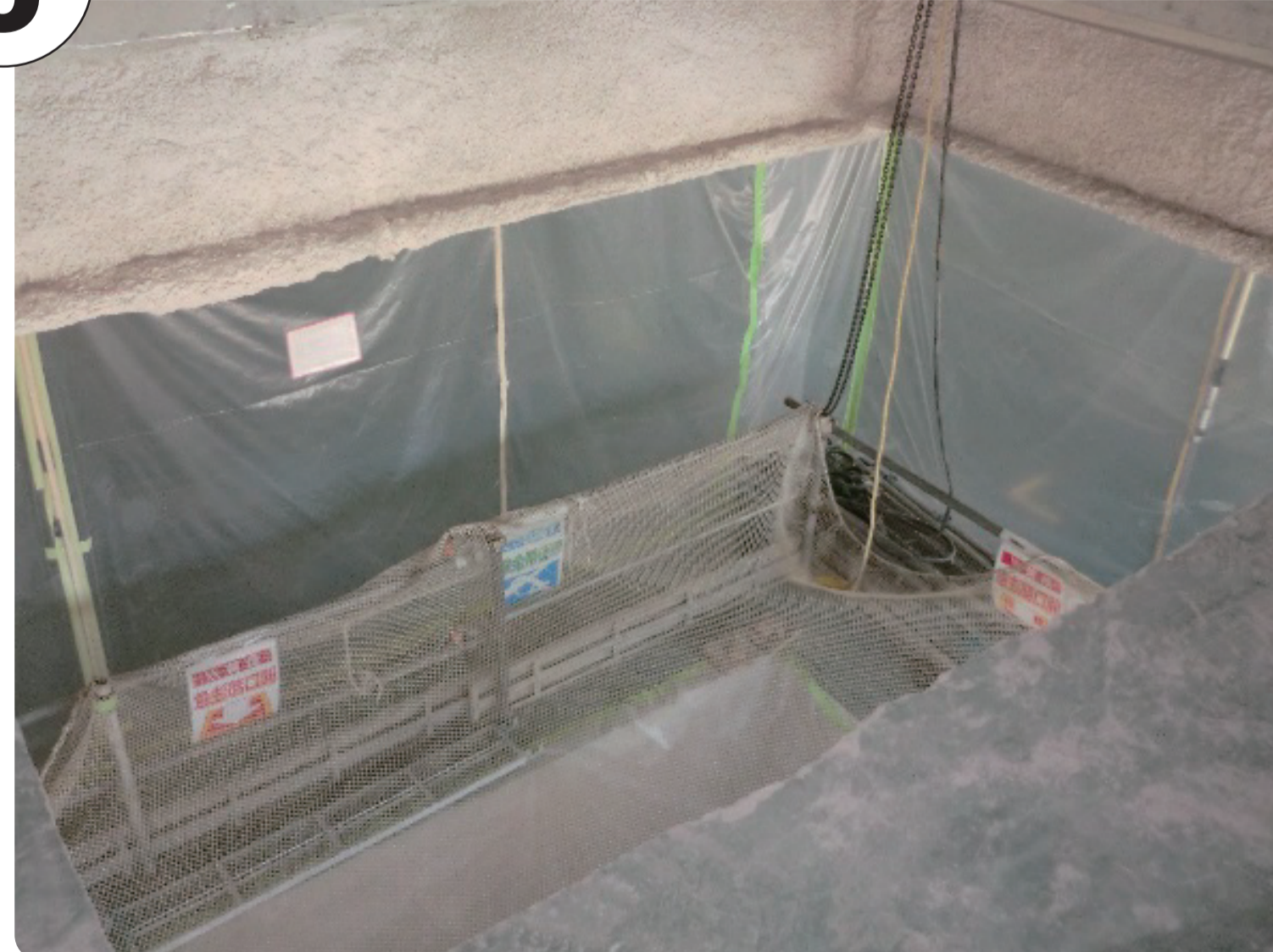
5 3階床スラブ開口完了
