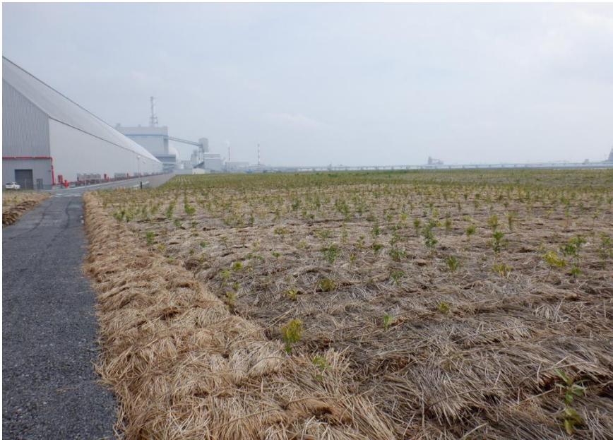
環境緑地 施工直後
