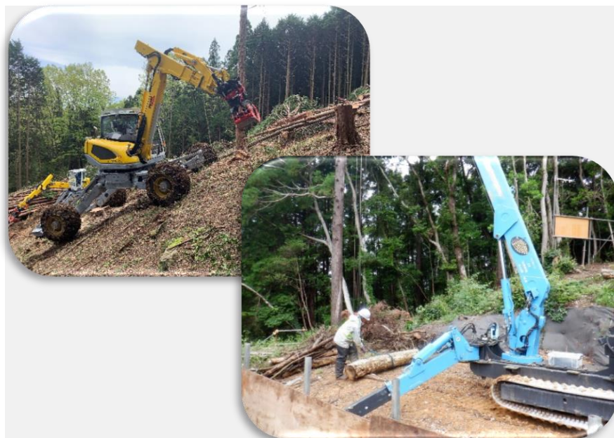
特殊重機による法面作業
