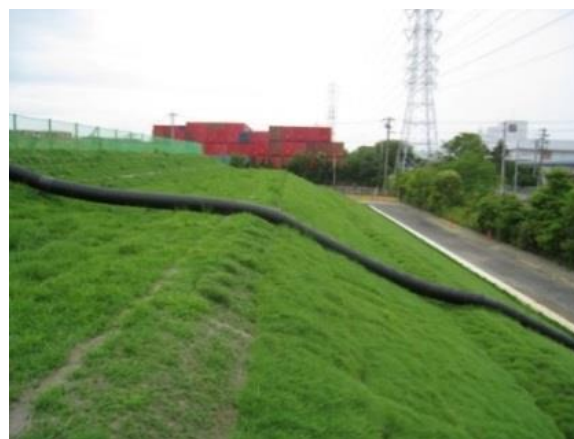
2017/7/14 施工後約3ヶ月
