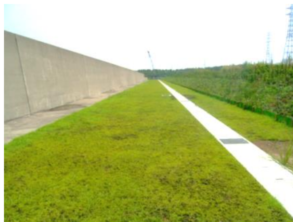
2013/8/8 施工後約1ヵ月目
