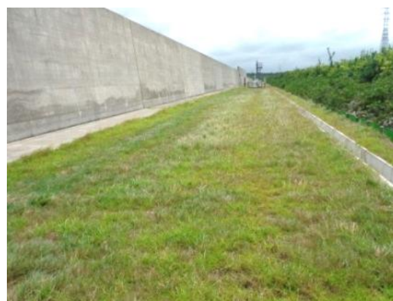
2016/8/17 施工後約3年目
