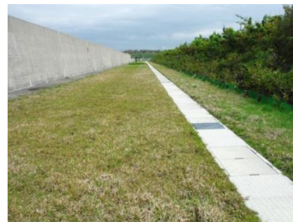
2018/5/17 施工後約5年目
