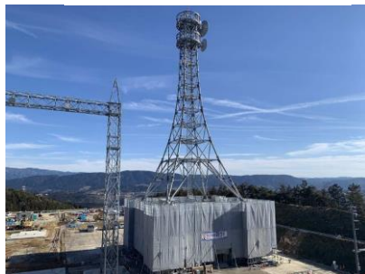
変電所 新設工事
